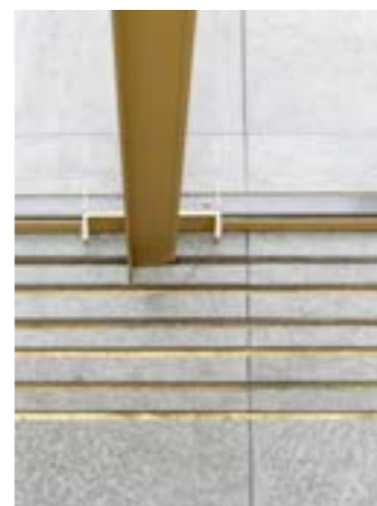
Schwellenfreier Bodenübergang mit zwei Laufbahnen
