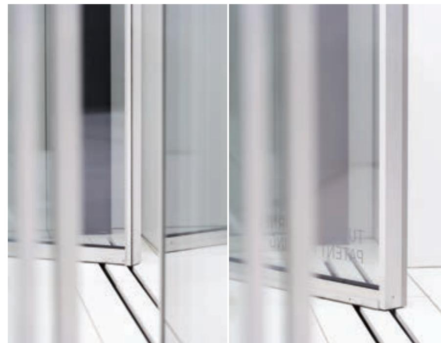
Cette solution architecturale majeure dégage tout l'espace sur les faces et les angles, tout en permettant de stocker les vitrages dans une zone dédiée. Les panneaux de verre peuvent atteindre une surface de 6 m<sup>2</sup> et un poids de 250 kg.
