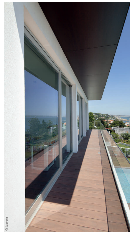
Les versions XXL sont intégrées au cœur de l'offre Kawneer. Pour exemple, la fenêtre Kaptiv offre un battent central avec battue centrée parmi les plus fins du marché en vue d'aluminium. D'autres options rendent la menuiserie discrète : drainage caché, barrette thermique à la couleur de la menuiserie, paumelles invisibles et poignée sans embase
